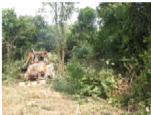
PEMBERSIHAN / PENYEDIAAN TANAH BAGI KAWASAN FASA 2
