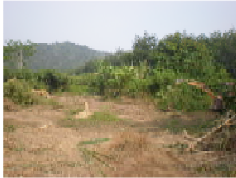
PEMBERSIHAN / PENYEDIAAN TANAH BAGI KAWASAN FASA 3
