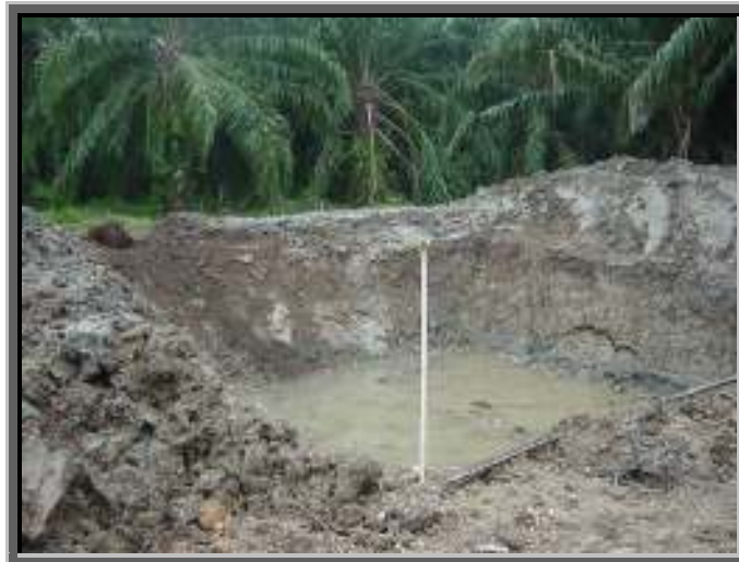
Tiga kolam kumbahan berukuran 30' x 40' x 10' dalam.
