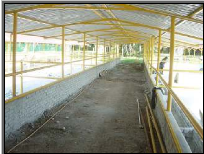
Kandang di peringkat kerja rangka dan simen
